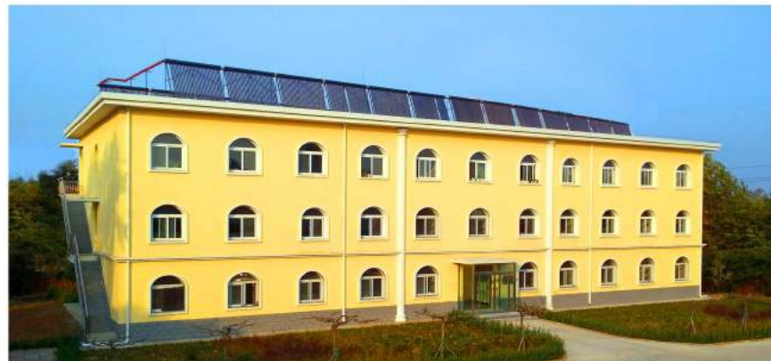
太阳能供暖采暖建筑实景
